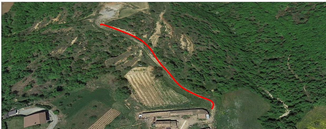
Fig. 1 - Strada di accesso interpodereale – Fonte www.pcn.minambiente.it
